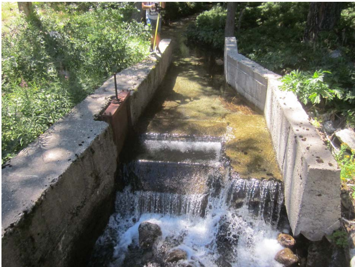
Снимка №7.Водохващане за поливни цели на територията на основното водохващане
