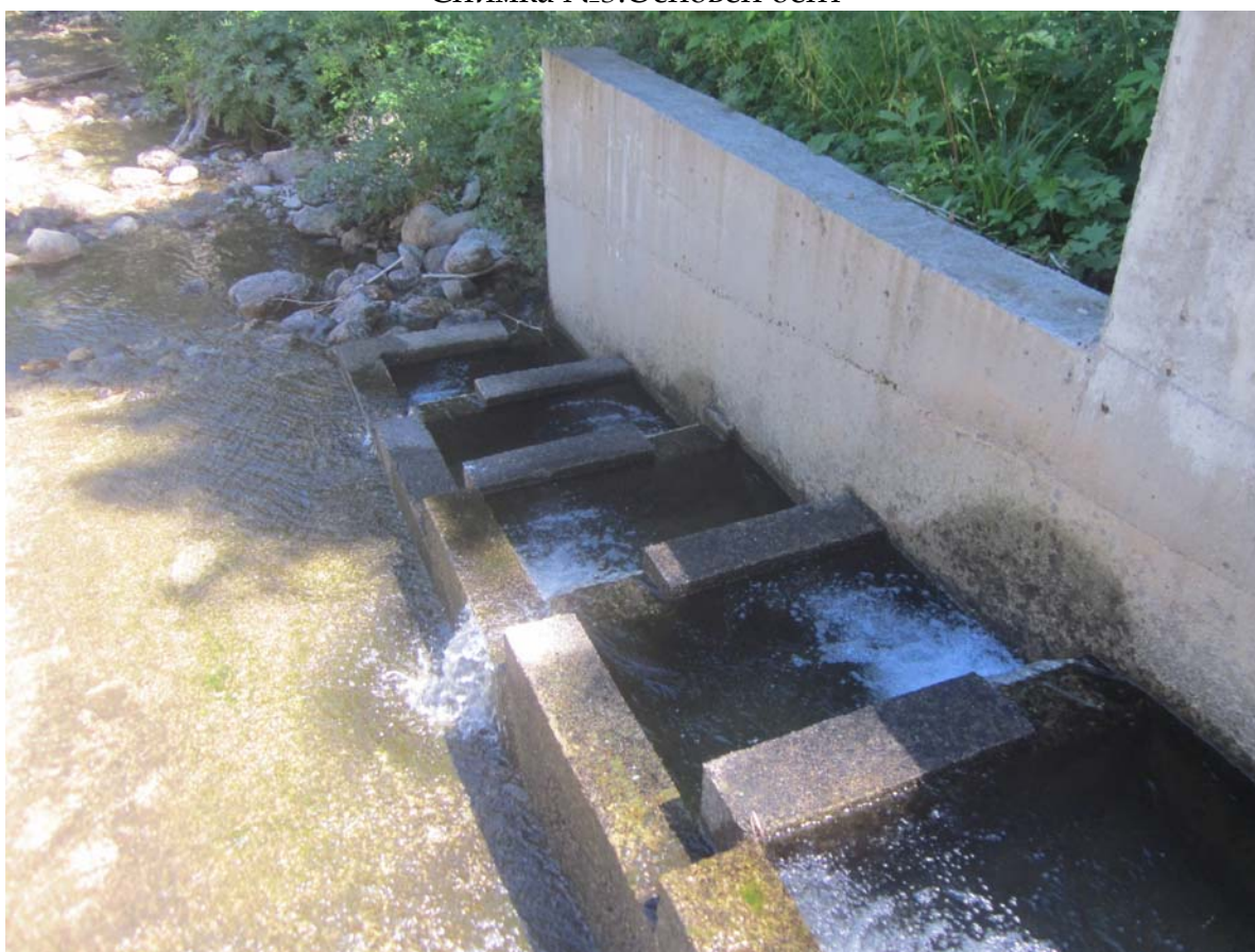
Снимка №4. Рибен проход под водохващането
