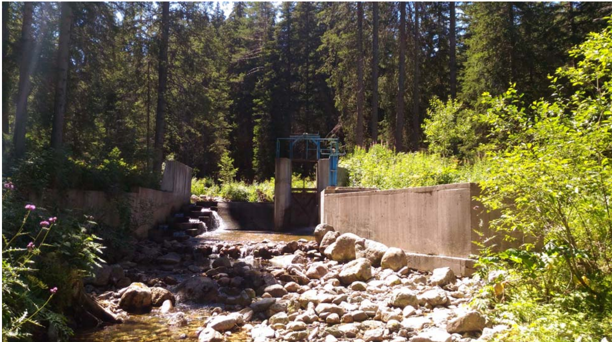
Снимка №1. Планинско водохващане на р.Прав Искър. Състояние към м.VIII.2017г
