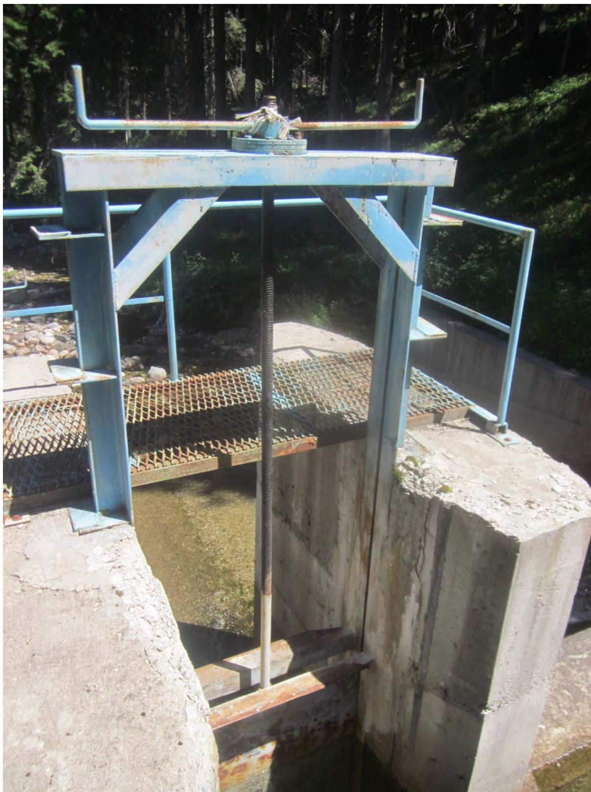
Снимка №2. Главен савак на планинското водохващане.
